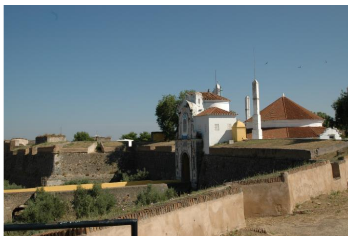
Fotografia 8 – Fortaleza: porta da esquina na frente poente
