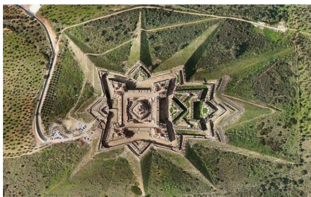
Figura 7 – Forte da Graça – vista aérea (Fonte: www.geodrone.pt , consultado em 2018)
